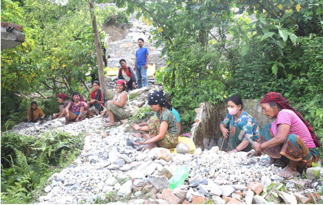
श्रमदानस्वरूप गिद्धी कुददै महिला : लमजुङ दोर्दी गाउँपालिका-४ स्थित गैरी आमा समूहको भवन निर्माणका लागि श्रमदानस्वरूप गिद्धी कुददै यहाँका स्थानीय महिला। यस आमा समूहले अनुमानित रू २० लाखमा दुईतल्ले भवन निर्माण गर्न लागेको छ। तस्विर : जनक श्रेष्ठ/रासस
