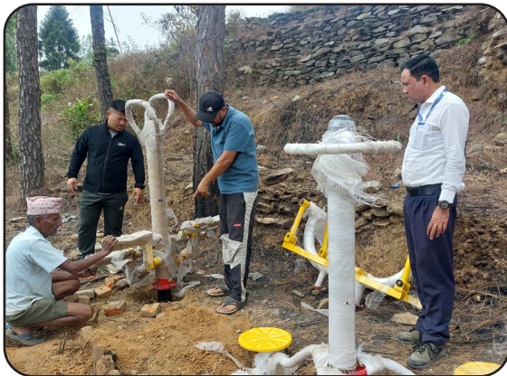
खुल्ला व्यामशाला निर्माण
