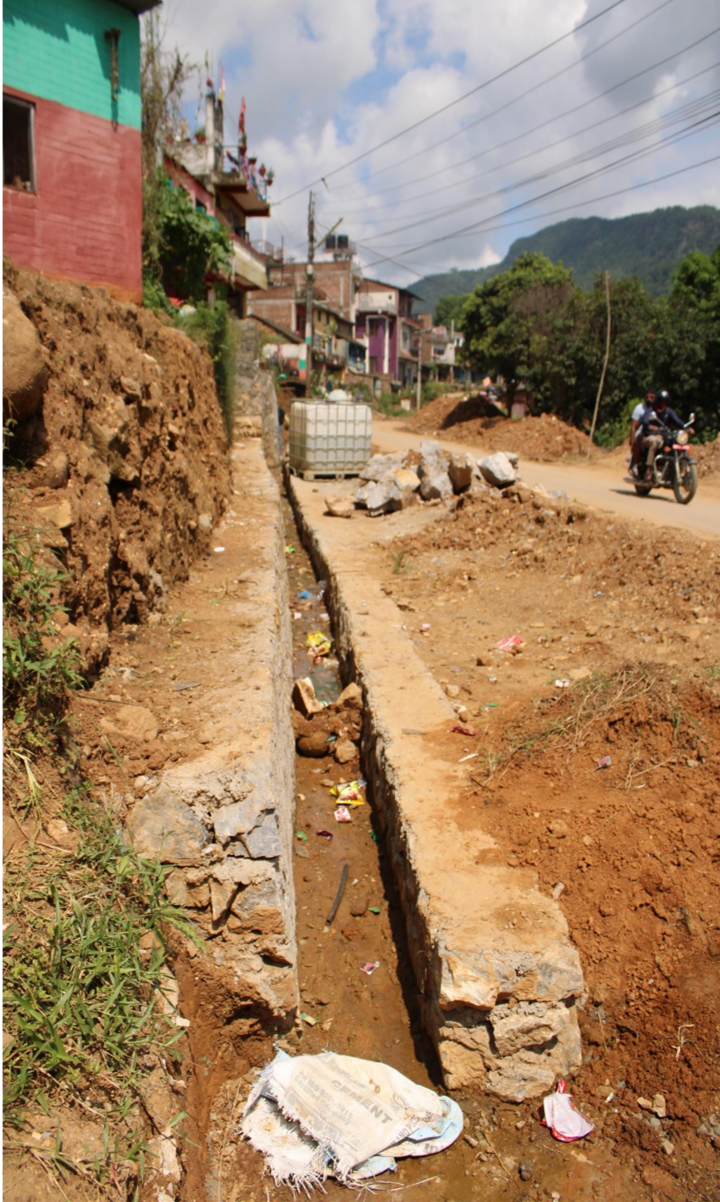
पिप्लेमा निर्माण गरिएको नाला
