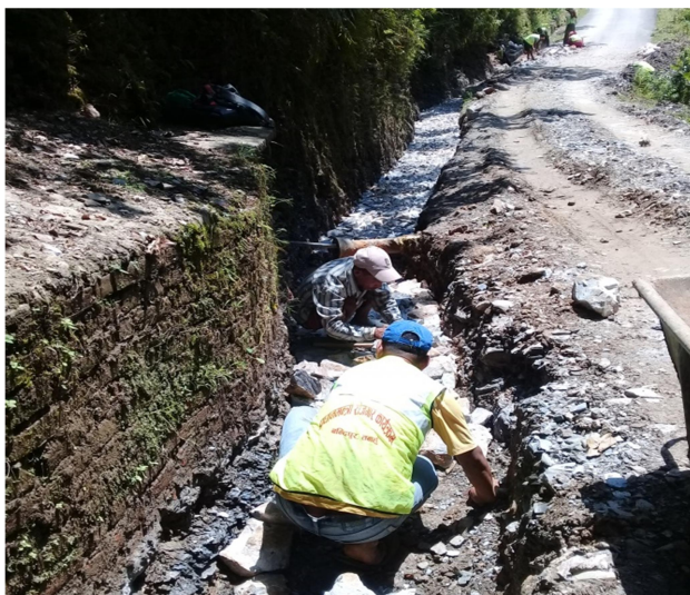
पुन्टेखोला नाला निर्माण
